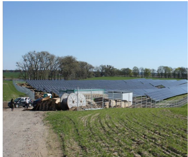
Instalacja fotowoltaiczna Roztocze
