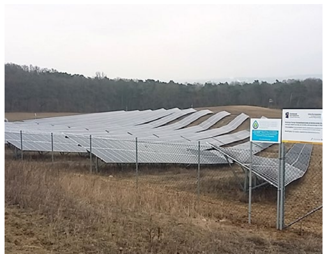
Instalacja SGE Pargowo
